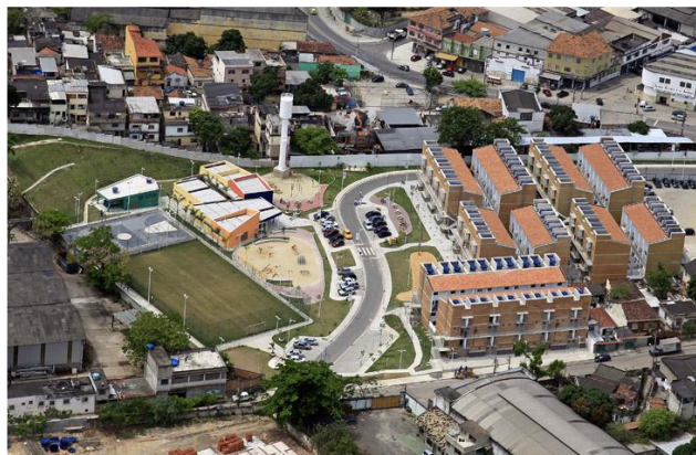
Figura 16: Novas unidades habitacionais construídas. Fonte: (JÁUREGUI, s.d.)
